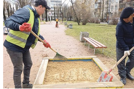
Замена песка во дворах на Софийской улице
